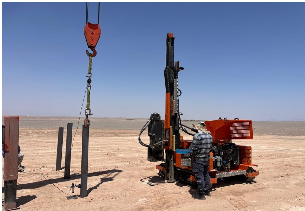
انجام تست پایه ها در حالت کششی ۹۰ درجه
