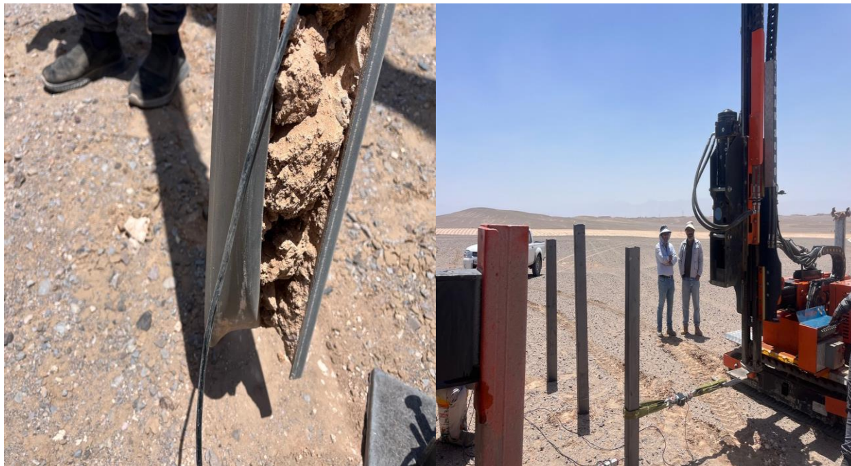
پایه کوبی در نقاط مختلف سایت با دستگاه پایه کوب سولار
